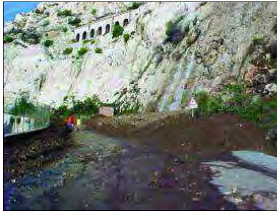
Coulée de boue du Rove ( SDIS 13 )
